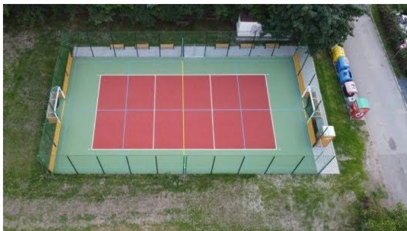
Víceúčelové hřiště Přemýšlení - dokončeno 07/2021
